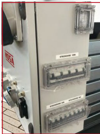
Sicherungen für die einzelnen Steckdosen
