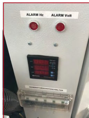
Anzeige V-Hz-A, Hauptsicherung, vom Traktor aus sichtbar
